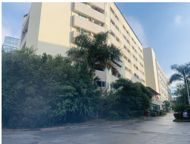
项目北面 工业厂房
