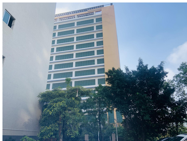
项目南面 工业厂房
