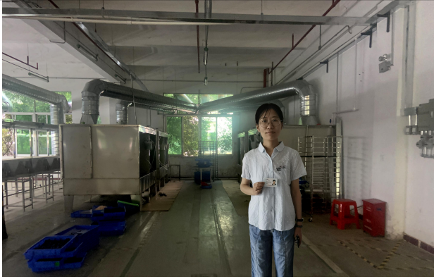
工程师现场持证照片
