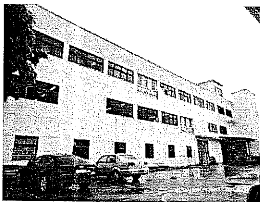
项目厂房现状
