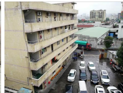
项目西面工业区宿舍
