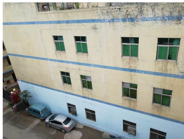
项目北面工业厂房
