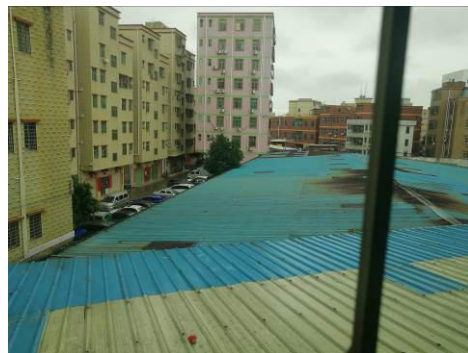
项目东南面铁皮房
