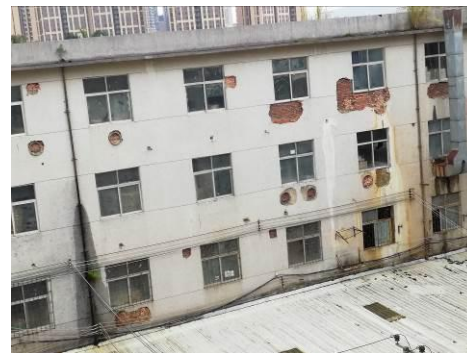
项目西南面工业厂房
